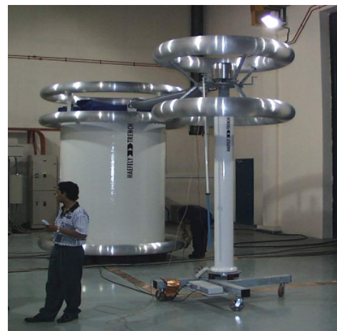
AC300kV 試験用変圧器 および 高圧分圧器
